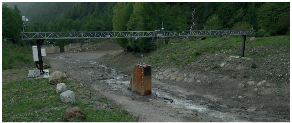
Monitoringstation Gadria – Überwachungs- und Alarmierungssystem Gadriabach in Südtirol. Wichtige Erkenntnisse über die Entstehung und Dynamik von Murgängen (Foto: © J. Hübl / IAN)
