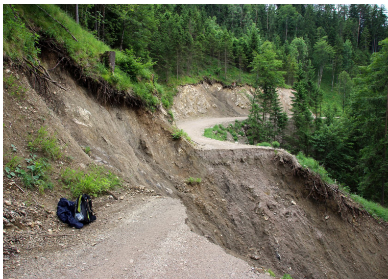
Rutschung im südlichen Niederösterreich (bei Hollenstein) nach den Starkregenereignissen im Mai 2014 (Foto: Karin Gokesch)
