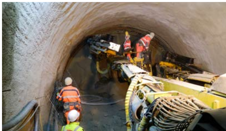
Tunnelvortrieb der U1-Verlängerung (Foto: W. Heriszt, 28. März 2014)
