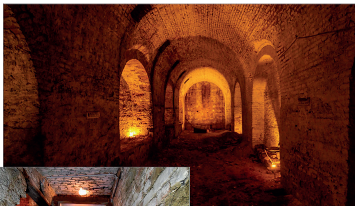
Blick in das unterirdische Kellersystem (Foto: © Unter Wien IG)
